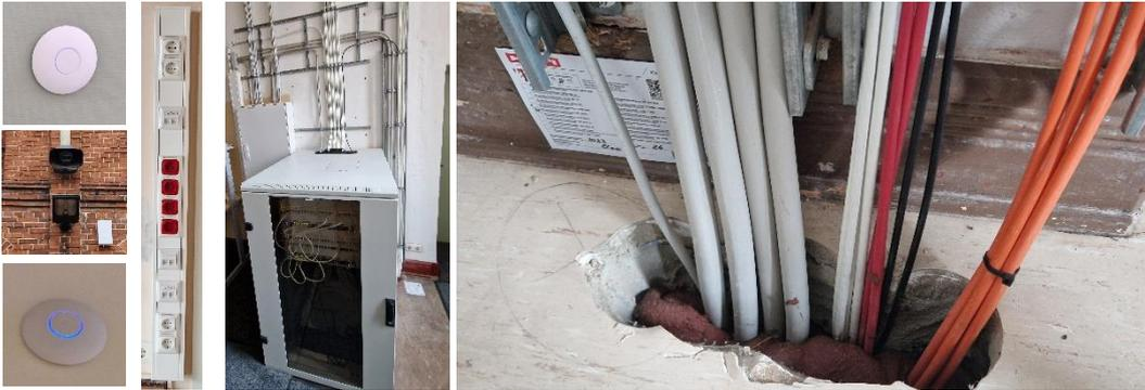
In den Räumen der neuen Stromversorgungs- und Datenverteiler sind jeweils neue Potentialausgleichsschienen montiert und mit dem Hauptpotential verbunden.
