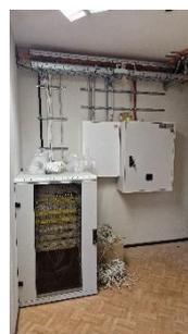
Die Leitungsverlegung erfolgt vorrangig in Leitungsführungs- und Brüstungskanälen in Metallausführung. Die Trassen in den Unterrichtsräumen führen, in Abhängigkeit der kaum veränderbaren Einrichtungen, parallel zu den Fluren und unterhalb der Decke.
